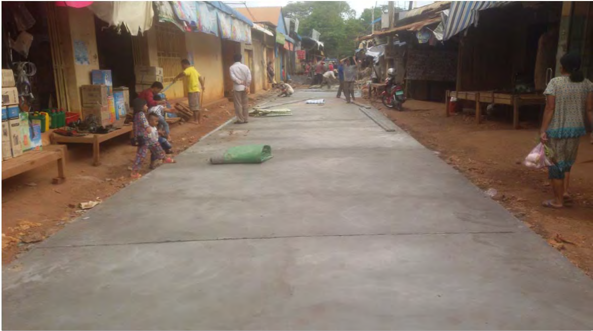
សាងសង់ផ្លូវបេតុងអាមេប្រវែង១ម នៅឃុំក្រែក ស្រុកពញាក្រែក៤ម ទទឹង០៣៤, ខេត្តត្បូងឃ្មុំ )Construction Cost= 201,348,000 Riels) មូលនិធិឃុំឆ្នាំ២០១៧
