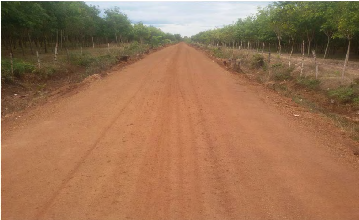
សាងសង់ផ្លូវក្រាលក្រូសក្រហមប្រវែង១ ម៣០០,១ទទឹង៤ម នៅឃុំកោងកាង ស្រុកពញាក្រែក ខេត្តត្បូងឃ្មុំ )Construction cost= 57,860,000 Riels) មូលនិធិឃុំឆ្នាំ២០១៧
