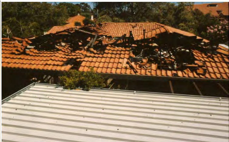
A រូបភាព : គ្រោងអាគារដែលបានបាក់ខ្ទេចខ្ទី ដែល បណ្តាលឱ្យមានគ្រោះថ្នាក់ដល់អ្នកធ្វើកោសល្យវិថីយ ។ (A) ផ្នែកខាងក្នុង (B) ផ្នែកខាងក្រៅ
