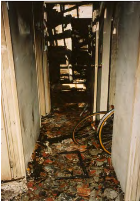
A រូបភាព : គ្រោងអាគារដែលបានបាក់ខ្ទេចខ្ទី ដែល បណ្តាលឱ្យមានគ្រោះថ្នាក់ដល់អ្នកធ្វើកោសល្យវិថីយ ។ (A) ផ្នែកខាងក្នុង (B) ផ្នែកខាងក្រៅ
